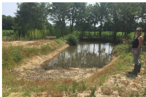
Janvier 2004, état de comblement après une saison de végétation : environ 30 cm de sédiments se sont déposés en 15 mois et 2/3 du bassin sont végétalisés.
